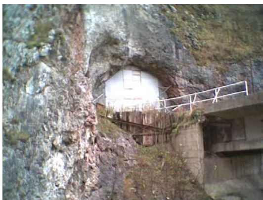
Sl.5. Tunel u Maloj rijeci prije betoniranja
